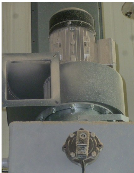
Рис. 3. Очистка воздуха от пыли в локальном фильтре не идеальная, и пыль может накапливаться в рабочем помещении
