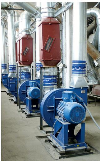
Рис. 1. Вентиляторы и устройства с защитной сеткой
