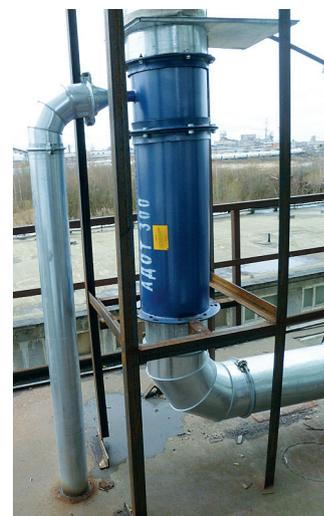
*Рис. 4. Пылеотделитель типа АДОТ с подводящим воздуховодом и воздуховодом для отвода уловленной пыли*
