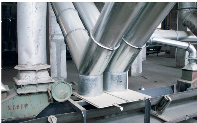
*Рис. 3. Приспособление (шиберная задвижка) для очистки воздуховодов*
