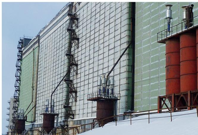
Рис. 6. Элеватор после реконструкции аспирационной сети
