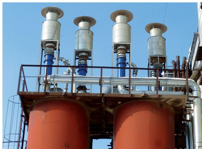
*Рис. 5. Пылеотделители АДОТ (с шумоглушителями), установленные на пылевых бункерах*
